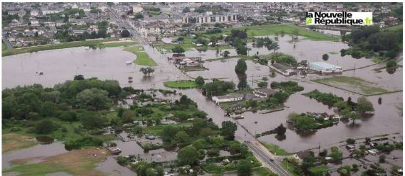
Figure 45 : Le déversoir de la Bouillie inondé, Blois, le 3 Juin 2016.
