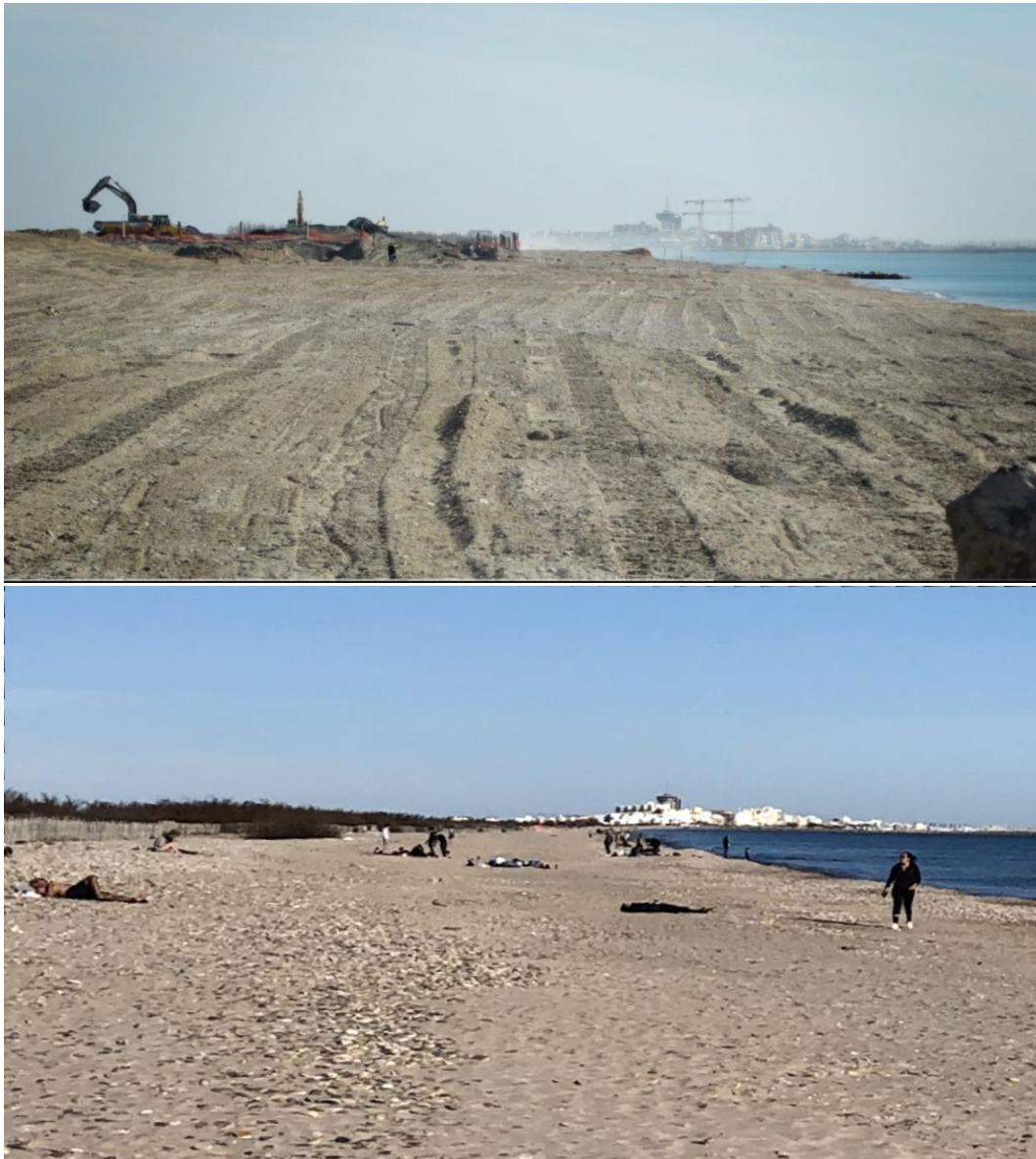
Illustration 19 : Résultat d'une comparaison avant/après lors des travaux de renaturation des anciens bassins aquacoles. Sur ce document, l'objectif de continuité de la plage et du cordon dunaire jusqu'à la commune de Palavas-les-Flots est bien visible (Photo : Département de l'Hérault, 2017 ; SaVE, 2024).
