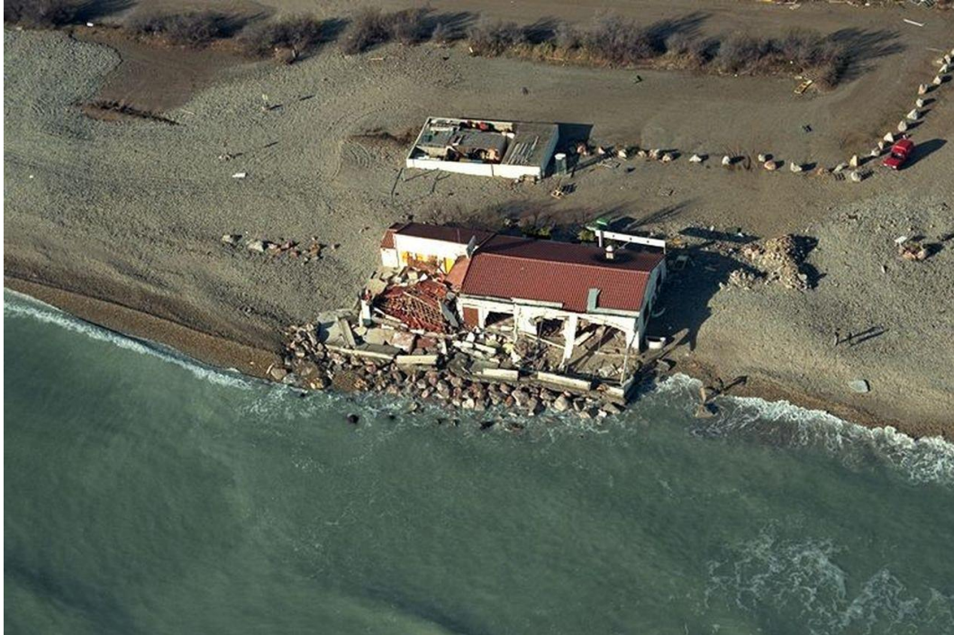
Illustration 3 : Le restaurant de plage « L'Escale » installé sur le site des Aresquiers, rattrapé par le recul du trait de côte et, ici, partiellement détruit par la tempête de décembre 1997, a été démonté au milieu des années 2000 (Photo : DREAL Occitanie).
